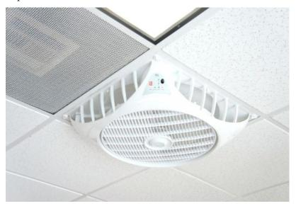
Kipas Fan berfungsi sebagai pengatur dan mempercepat sirkulasi udara. Alat ini bekerja dengan metode menghisap udara di dalam ruangan untuk kemudian dibuang ke luar ruangan. Pada dikala cara kerja membuang udara dari dalam ke luar tersebut, secara bersamaan alat juga meresap udara segar dari luar ruangan untuk dihembuskan ke dalam ruangan.
