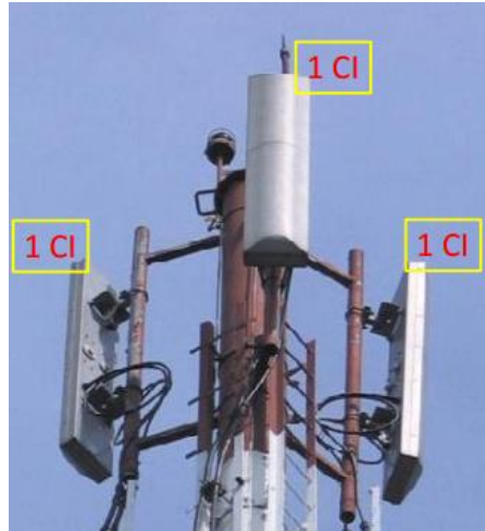
Gambar 3.6. Cell ID yang dikonfigurasi sebagai ID dari antenna BTS
