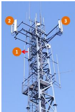
Gambar 3.7. 3 Sektor berbentuk Segi Enam di BTS
